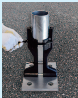
③保護材のくぼみ1ヶ 所または2ヶ所を固定 バンドで巻き締めます。
