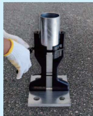
④止め器具の余り部分 をニッパーで切り落と します。
