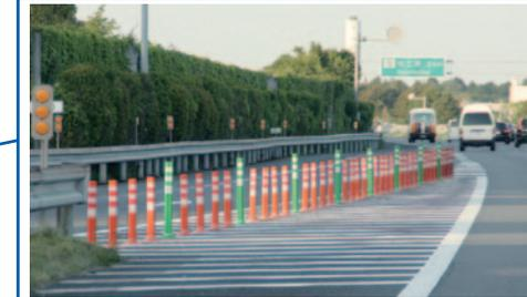
本線合流部に車線分離標の間隔をせばめて設置し、右左折による逆走を防止
