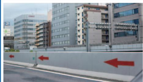
本線合流部の壁面に超高輝度反射材の矢印型で進行方向を示し逆走を防止
